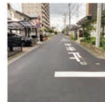
▲ 城東1丁目地内 道路整備
