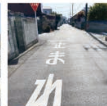
▲ 駅南4丁目地内 道路整備
